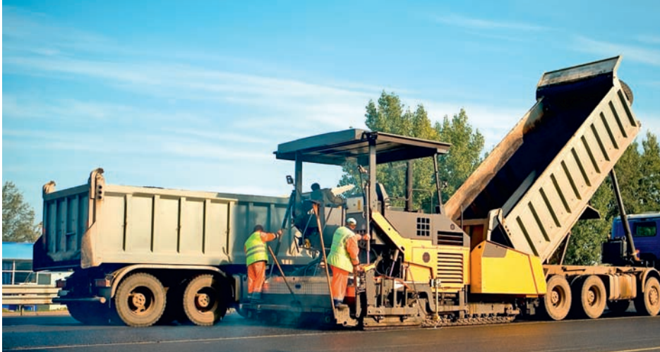
Bild 2: Durch Echtzeitsteuerung werden Steh- und Wartezeiten von Mischgut-Lkw und Fertiger vermieden
