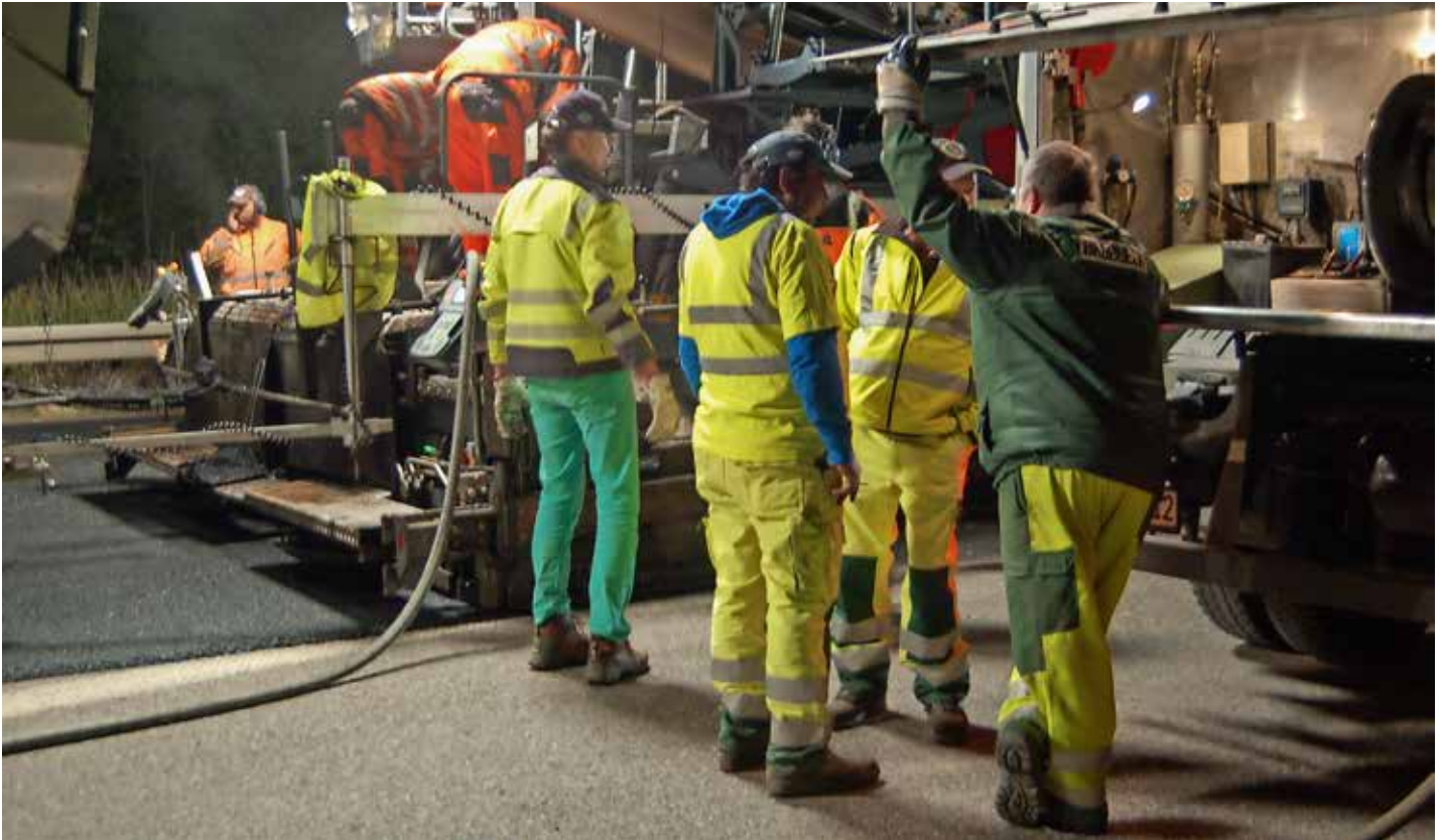
Auch die Betankungsvorgänge beider Fertigerzüge mussten, um einen möglichst unterbrechungsfreien Einbau zu gewährleisten, koordiniert werden
