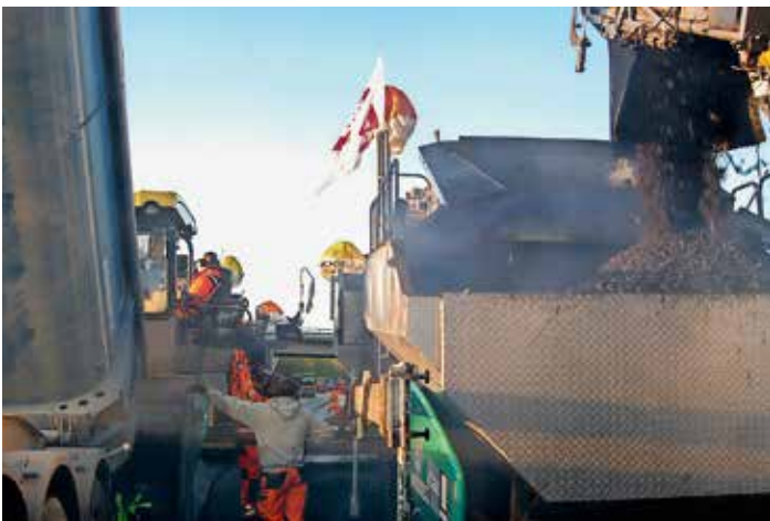
Gigantische Mengen bei zwei Kompaktasphalteinbauzügen: Die Einbauleistung liegt zwischen 450 und 600 t/h; der Lkw-Takt zwischen 2 und 3 Minuten
