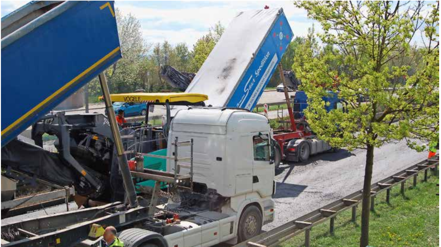
Samstagmittag: Die Materialzulieferung zu den Fertiggern erfolgt im geplanten Takt
