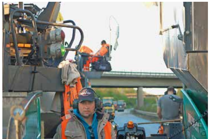
Alles im Plan. Unaufhaltsam bewegen sich die beiden Fertigerzüge Meter für Meter fort und halten den Abstand unter 20 m
